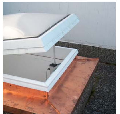
Beispiel: Lichtkuppel Betätigung Solo direkt an HSK (Rahmen- bzw. Kranzmontage)
